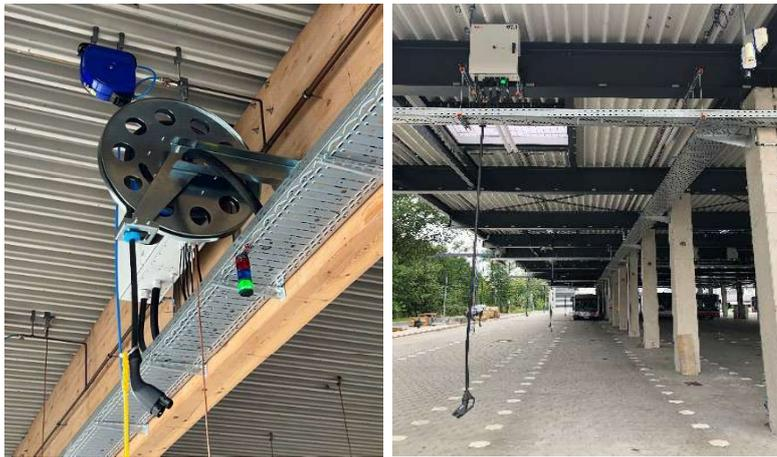
a) Kabeltrommel mit Rückspulfunktion;
